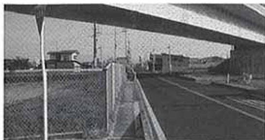
①整備前：波打歩道状況
