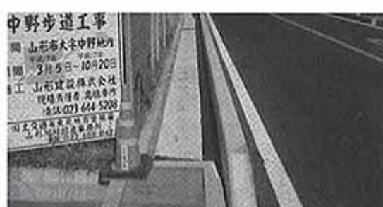
④舗装仕上げ用側溝蓋・歩車道境界 Br 設置
