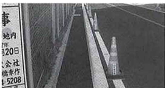
⑤整備後：表面舗装仕上げ
