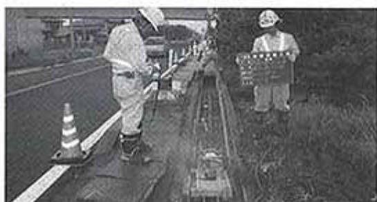
③水平カッター機（新技術）での側溝切断
